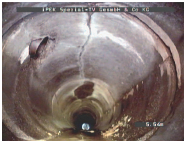
Bild 6: Altkanal vor der Sanierung
