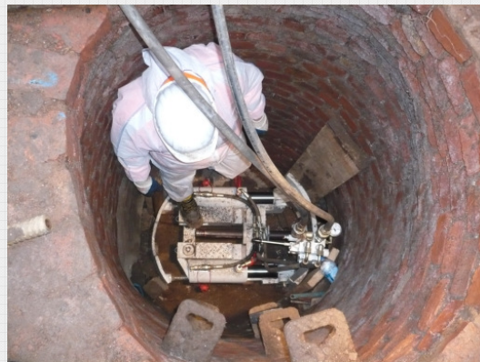
Bild 5: Zielschacht
