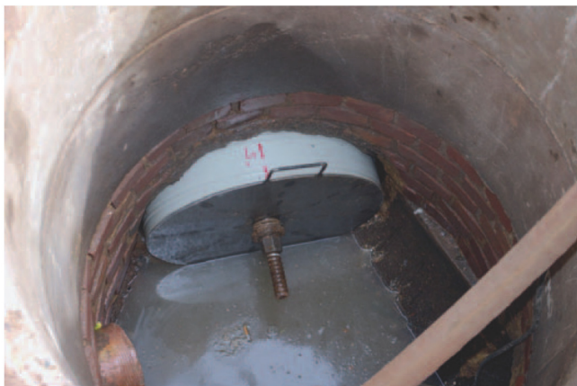
Bild 4: Rohrmodul während des Einziehvorgangs im Startschacht
