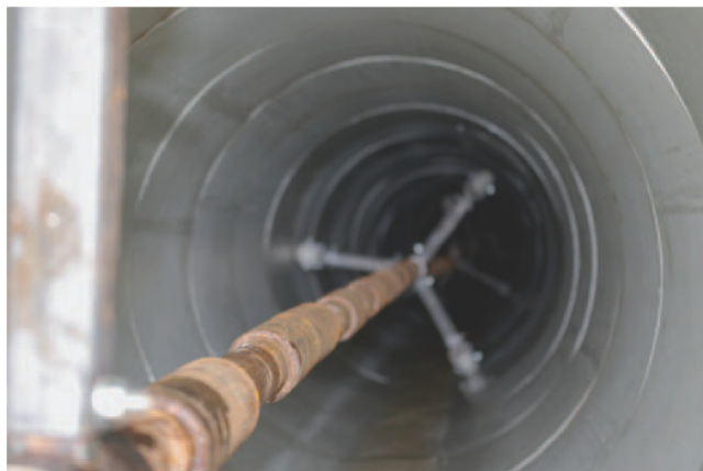
Bild 5: Zentrierter Zugstange während des Einziehvorgangs
