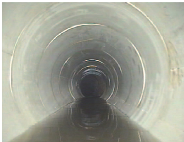
Bild 7: Mit PP-Kurzrohr-Modulen sanierter Kanal
